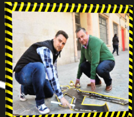
COLOCACION DE VINILOS EN SEGOVIA
