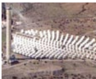
CENTRAL SOLAR TERMOELÉCTRICA Fuente: ABENER
