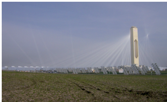
Imagen 2. Planta termosolar. Receptor central en torre
