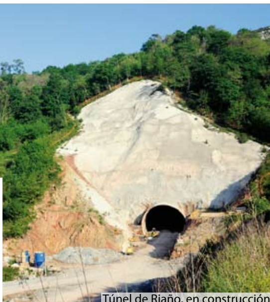
Túnel de Riaño, en construcción
