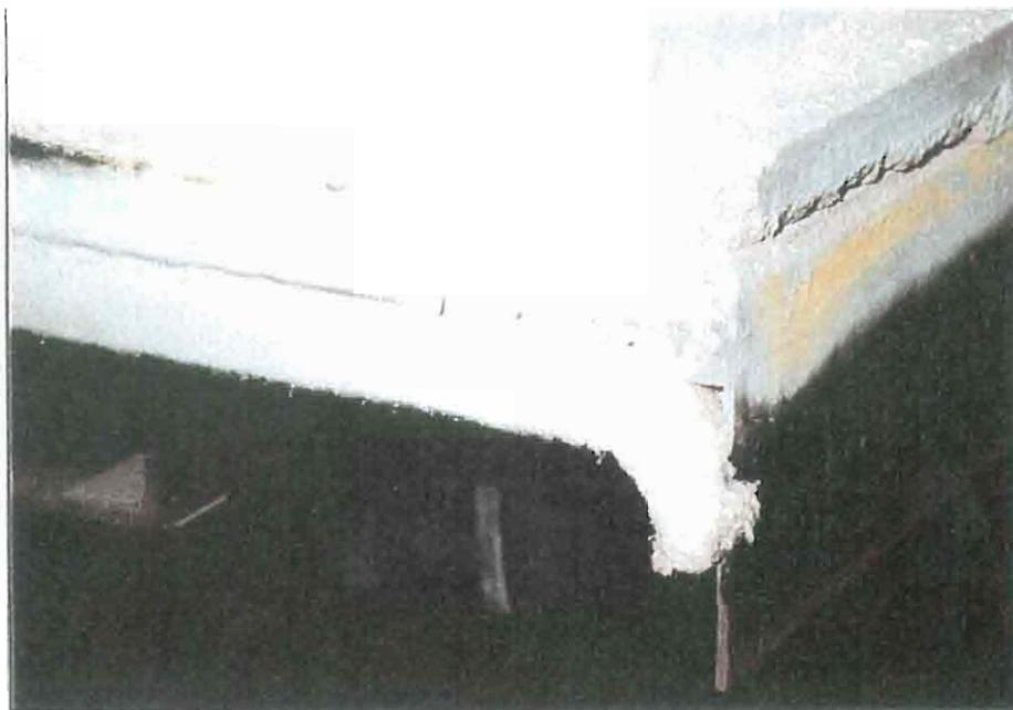
*Amianto utilizado en hornos para la cocción de ladrillos*
